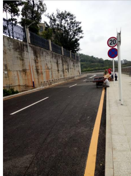
项目限速标志和保持路面平整
