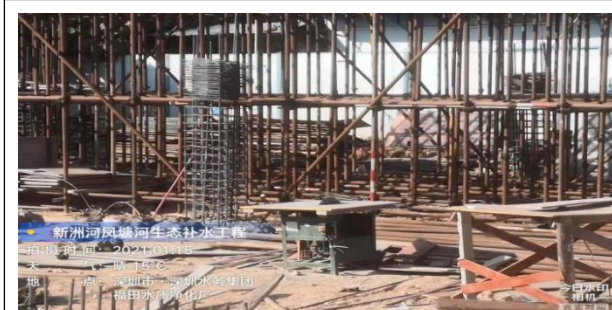
图 12 外脚手架与墙体间空隙未按要求设置安全水平兜网。
