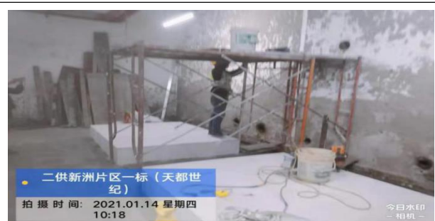
图 13 天都世纪操作平台无防护栏杆，脚手板未满铺
