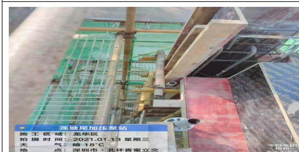
图 12 外脚手架与墙体间空隙未按要求设置安全水平兜网。
