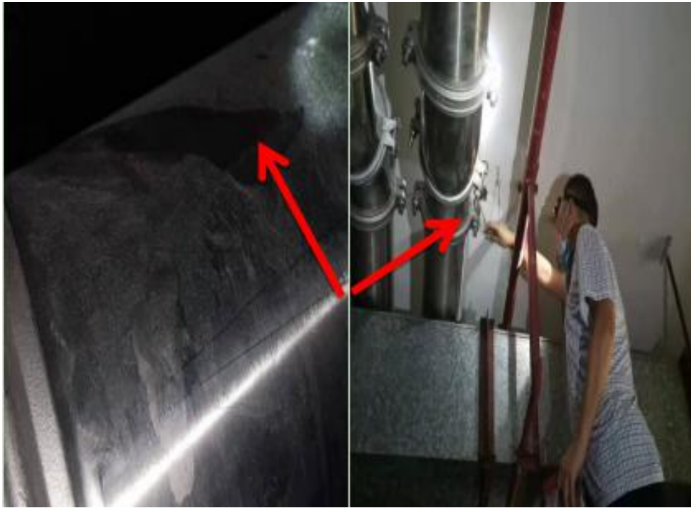
(图七) 事发点处有新的摩擦和高温烧过的痕迹。
