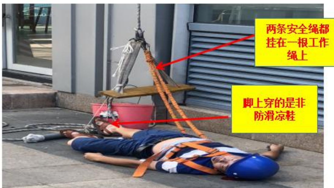
图片显示：事发现场只有一条工作绳（无生命绳），涉事工人身上安全带的安全绳违规扣系在工作绳上；另脚上穿的是凉鞋，并非防滑软底鞋。
