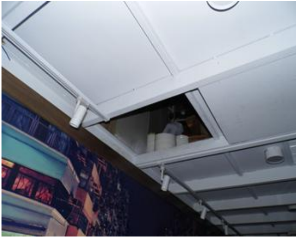
检修口入口处
