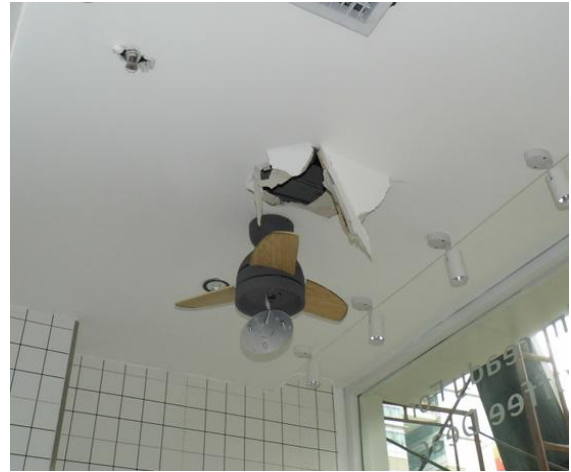
灯箱转换器安装位置
