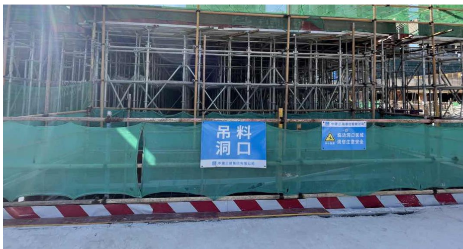
图 7 吊料洞口周边防护设施状态图
