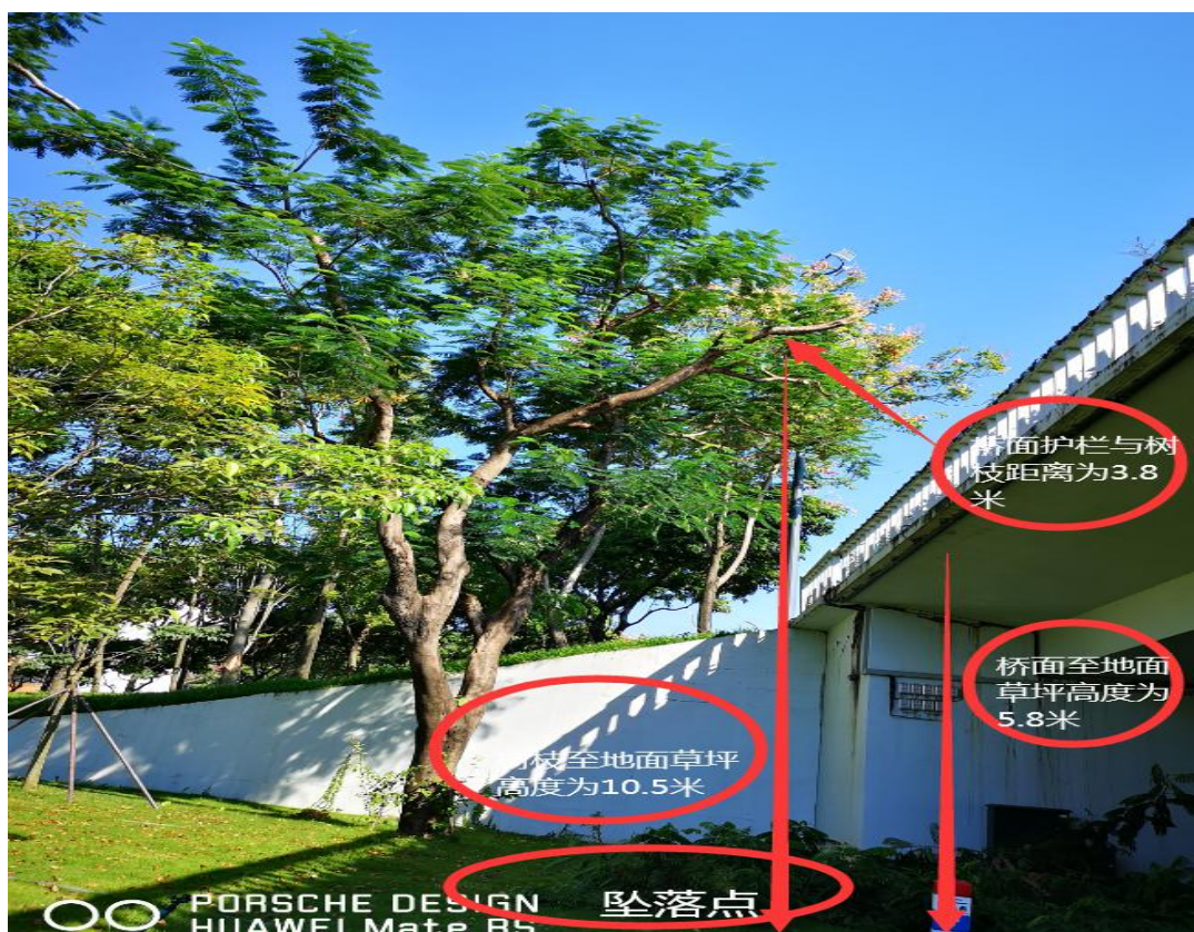
桥面至地面草坪高度为 5.8 米，桥面护栏与树枝距离为 3.8 米。
