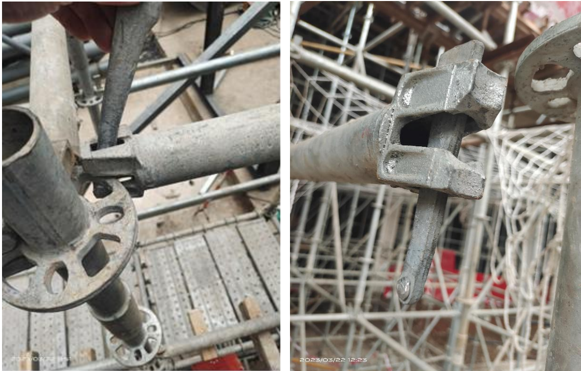
图 4 第 6 档水平杆现场图
