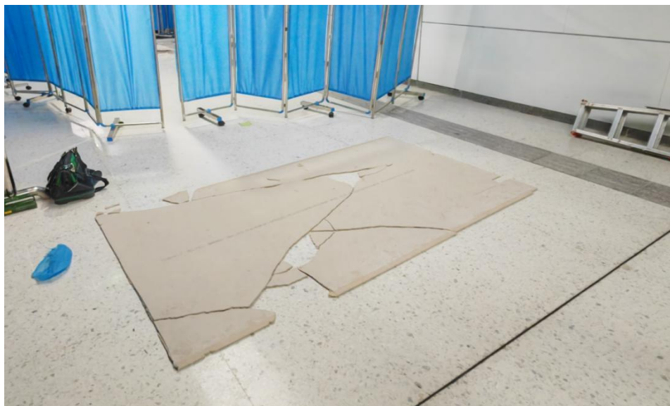
图 1 现场事发硅酸钙板图
