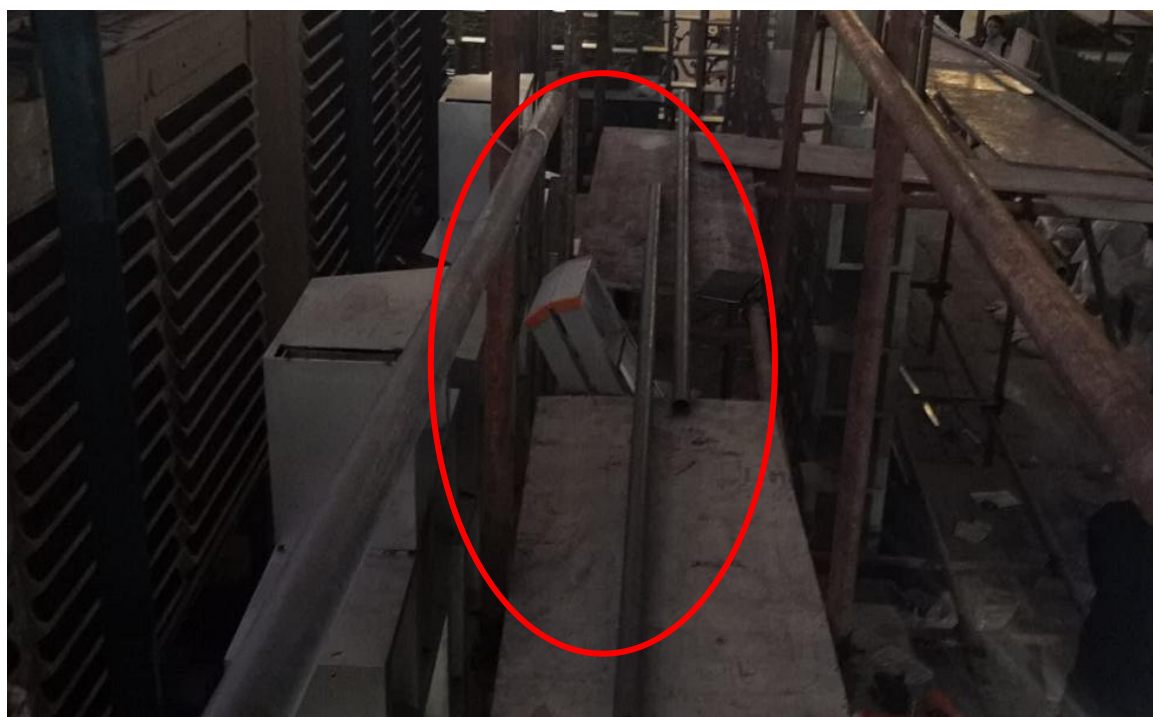
冉某斌在脚手架上的站立面
