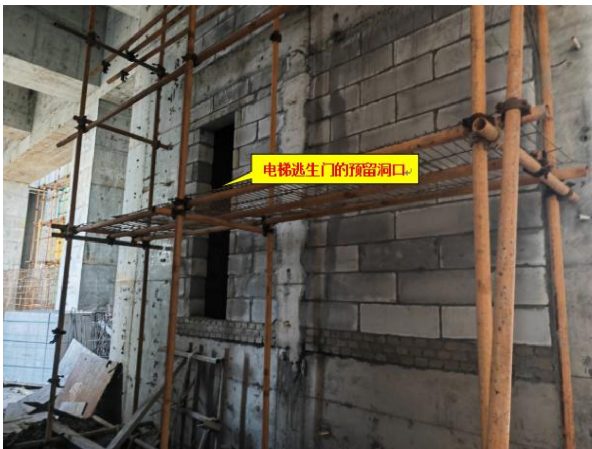
图 1 T5 栋 B3 区三层北面电梯间的脚手架
