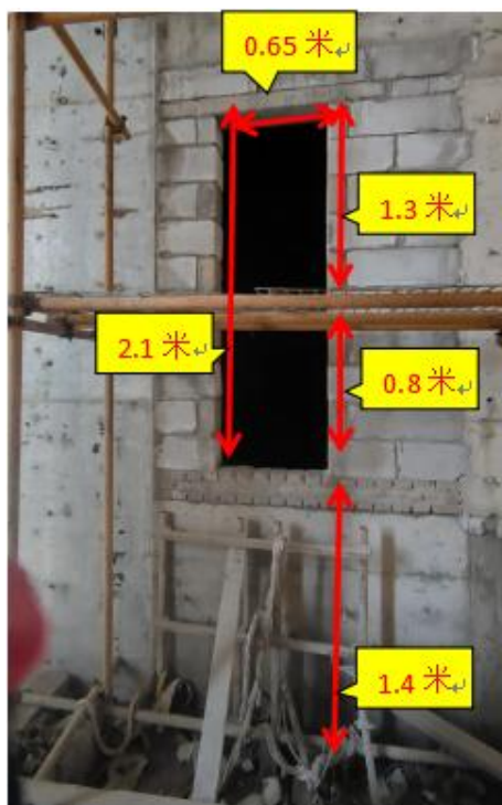
图 3 T5 栋 B3 区三层事发电梯口尺寸
