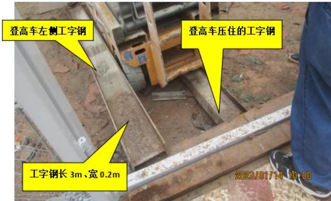
图4 勘查时工字钢状态图
