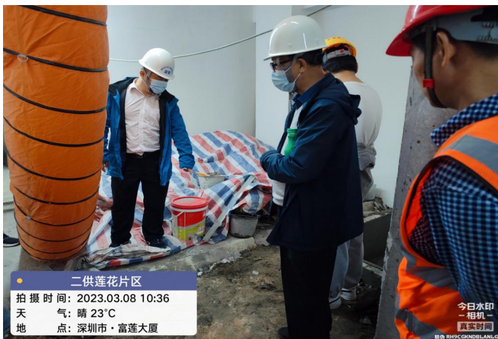
2023年3月8日对福田区居民小区二次供水设施提标改造工程-莲花片区进行复工复产监督检查。
