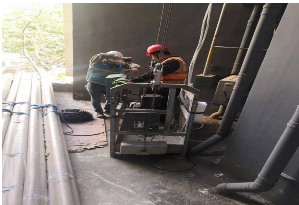
2023年3月2日对福田区第七期优质饮用水入户工程（第六批）施工总承包项目深康村现场高空作业吊篮检测、检查。
