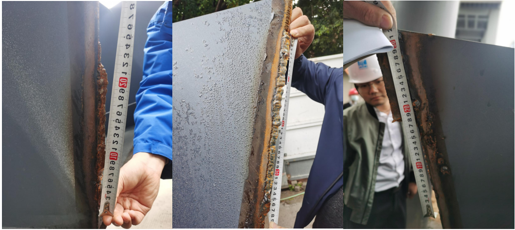
梯段钢箱梁西侧端部残留焊缝接头
