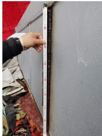
梯段钢箱梁东侧端部残留焊缝接头
