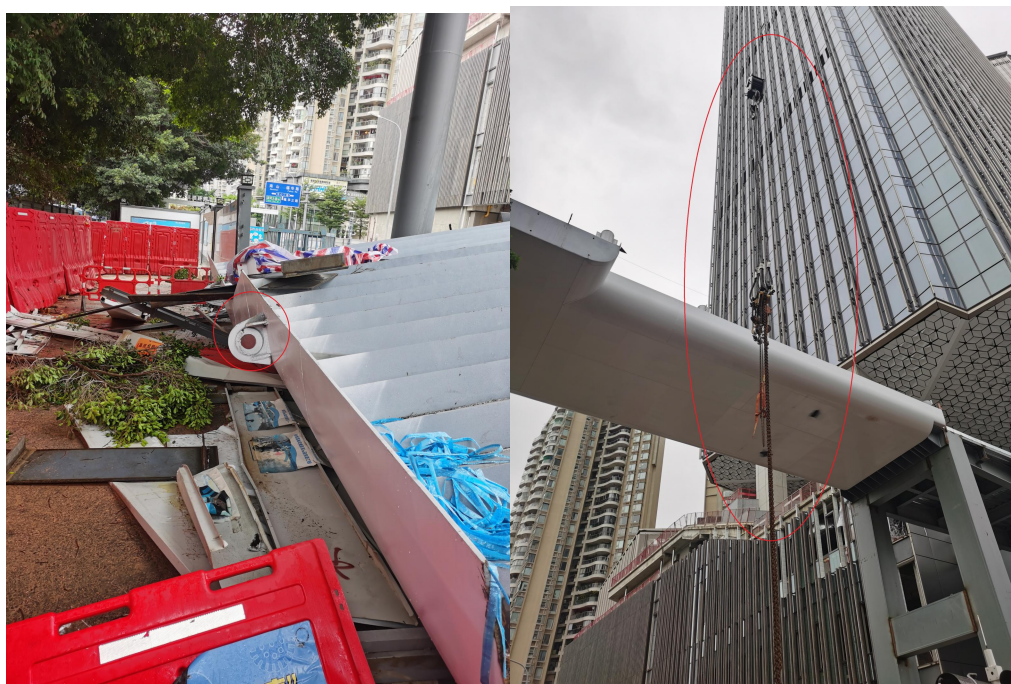
梯段钢箱梁吊耳及汽车吊吊钩吊索
