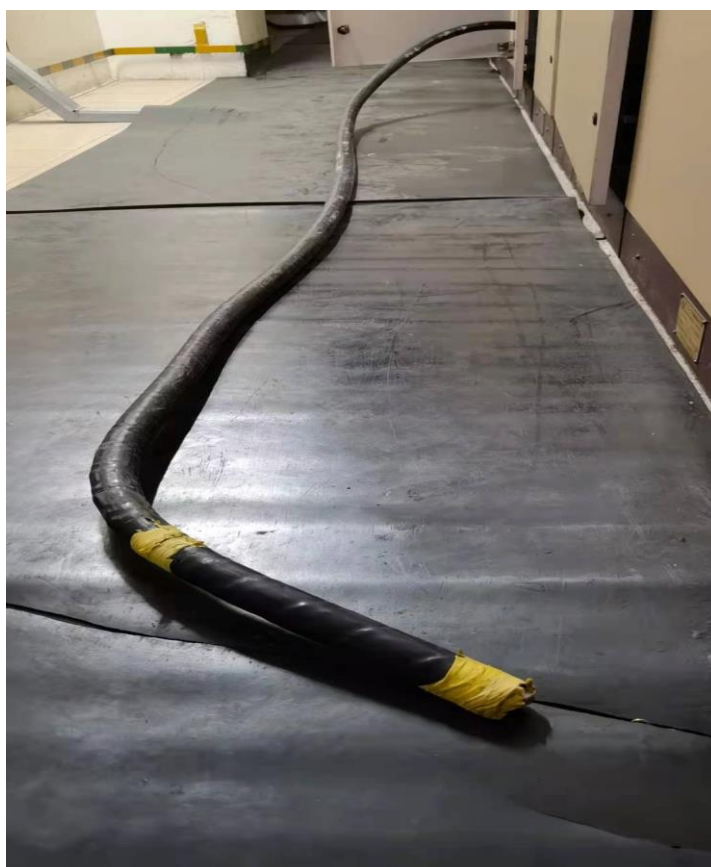
现场进行铺设的电缆（尚未与电箱接驳）
