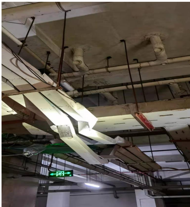
顶部线槽状况，线槽底部距离地面为 2.78 米
