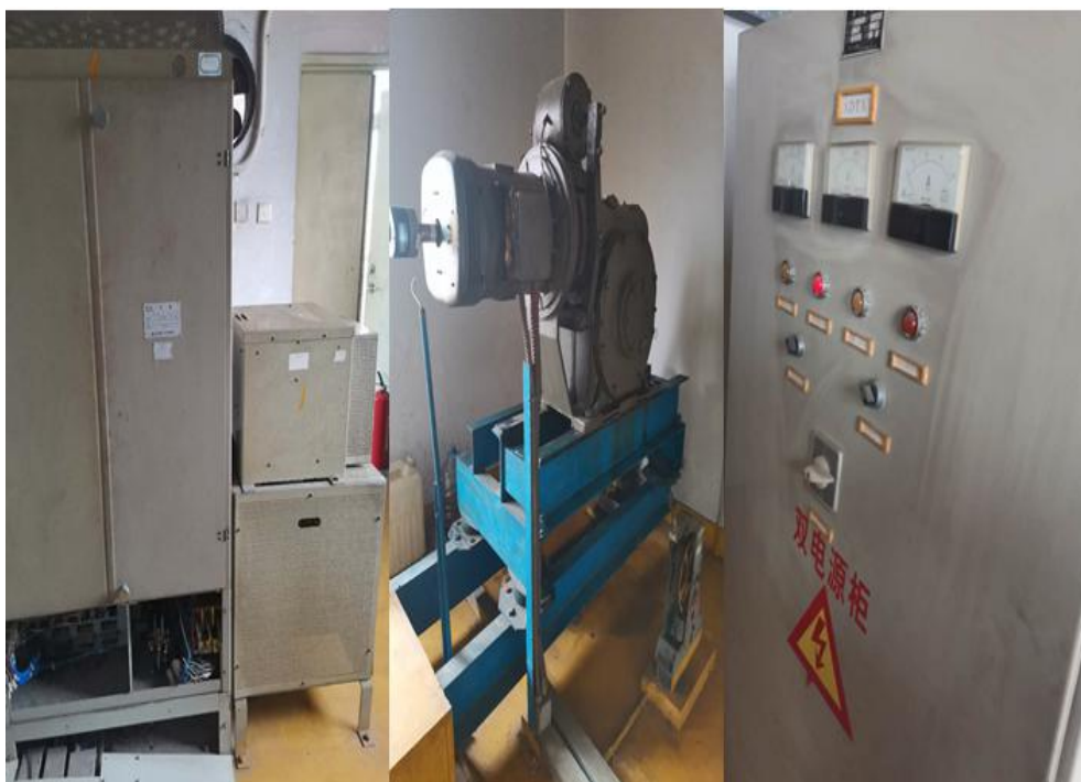
电梯设备房内设置有电源箱（配电柜），控制柜、电梯曳引机设备（具有危险性设备）。
