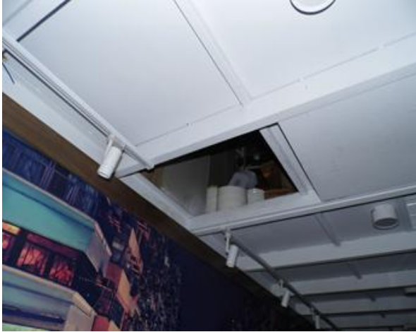
检修口入口处
