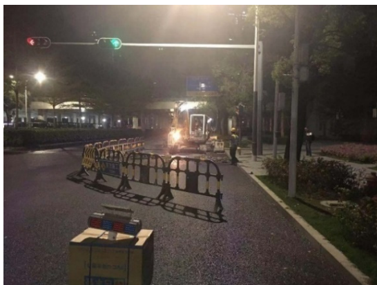
紧急性占道作业、道路及设施养护
