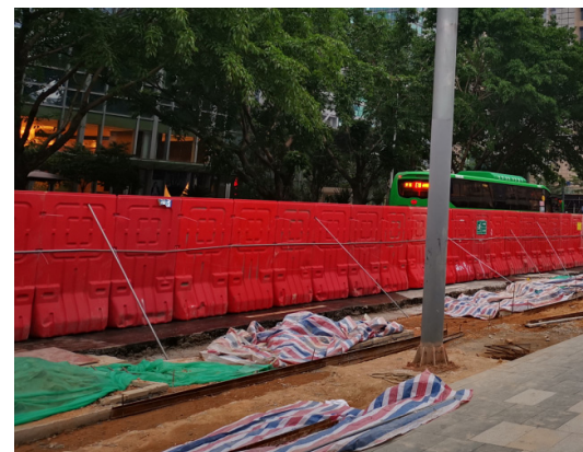
常规市政工程项目
