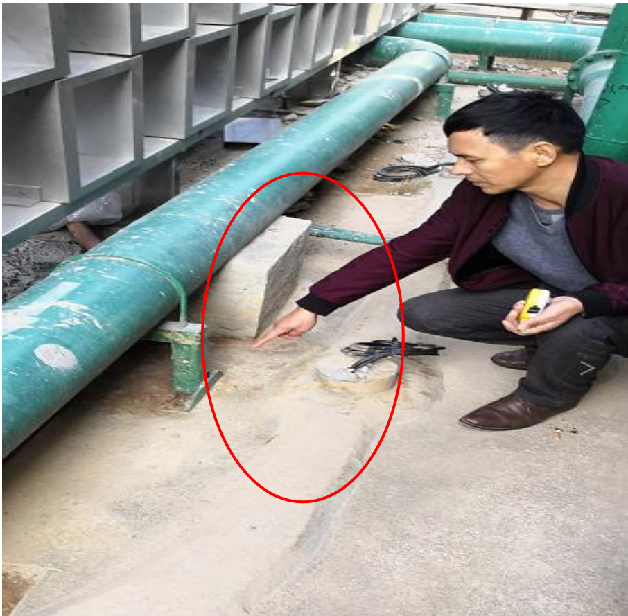
冉某斌在脚手架上高坠后的坠落位置
