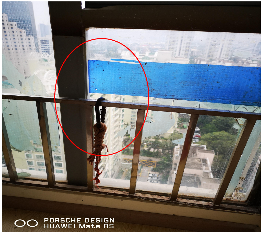
2、下图为福田区五洲星苑小区C栋26D房空调室外机安装的作业面及遗留在现场的作业工具。
