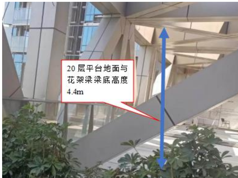
图 6 20层花架梁现场勘查图
