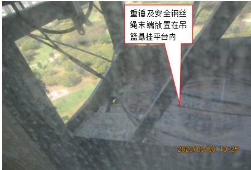
图 5 外墙高处作业吊篮勘查图
