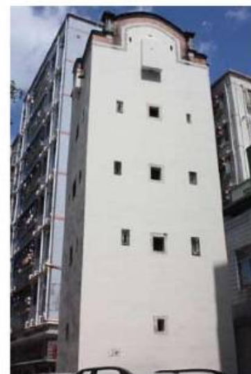
◎ 碉楼（摄于2013年，石厦股份公司供稿）
